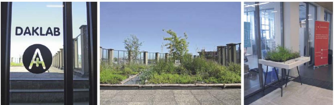
Abb. 3: Das Daklab auf der Hogeschool Amsterdam: ein nachträglich implementiertes Dachlabor auf dem Dach der Fachhochschule, an dem Studien zur Rückhaltung und Verdunstung von Niederschlagswasser durchgeführt werden. Die dort gezüchteten Kräuter werden auf Präsentationstischen innerhalb der Hochschule ausgestellt und die Maßnahme „Dachbegrünung“ wird erläutert.
